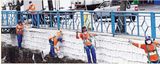
Equipe de serviços gerais, da unidade de Itu/SP, realizando a pintura do córrego da Avenida Octaviano Pereira Mendes.
