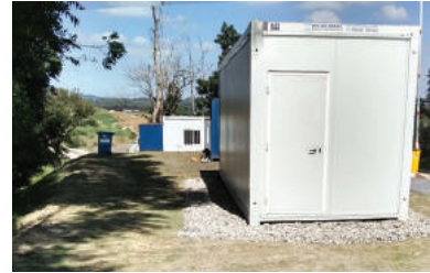
Refeitório do aterro de inertes.
